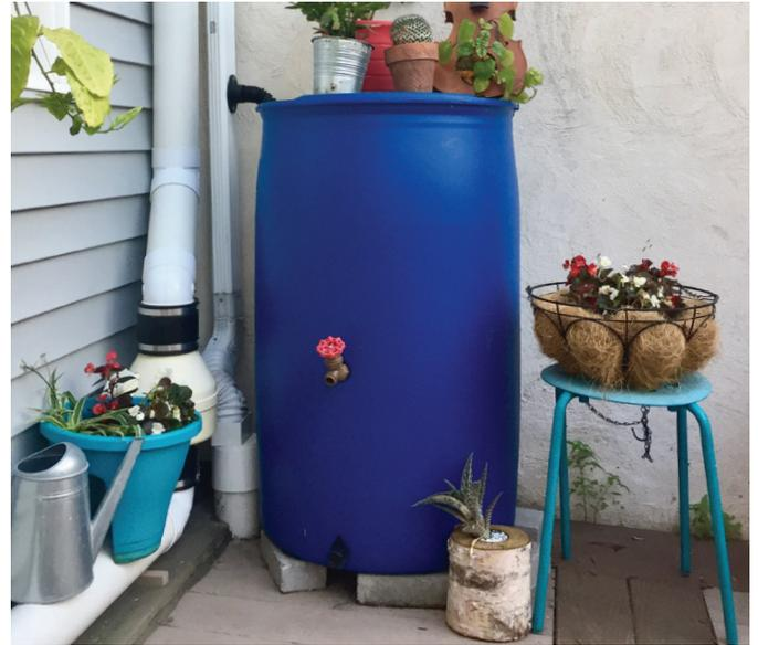
dos tornillos que mantienen conectada la tapa de goma para invierno al bajante. Retire la tapa para invierno y almacénela en un lugar seguro hasta el próximo invierno.
